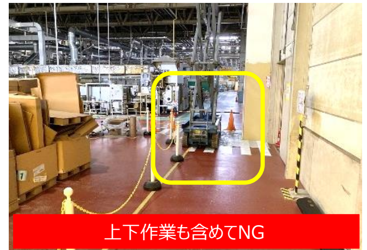
事例：高所作業車廻り区画不足
