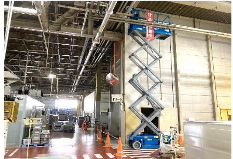
事例：通路直近の高所作業で監視人配置していない
